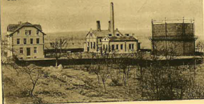
Gaswerk der Stadt Neckarsulm
