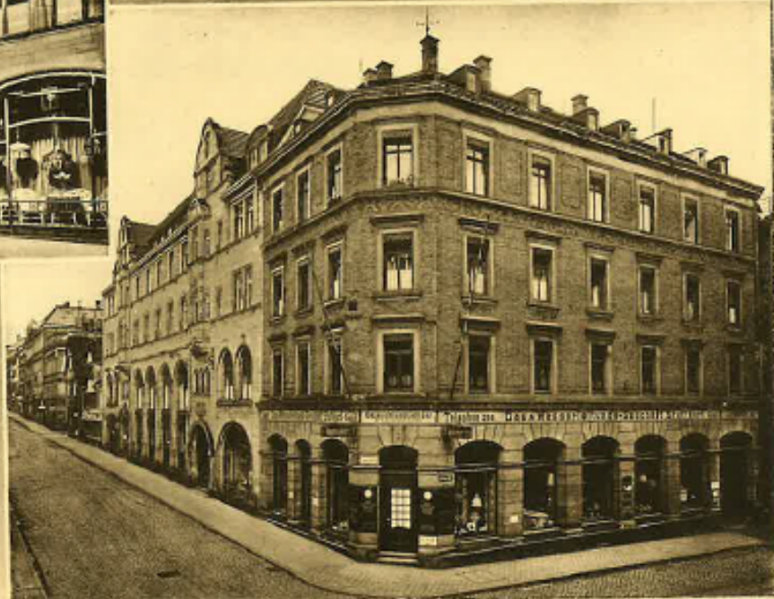
Gesamtansicht der beiden Geschäftsgebäude
