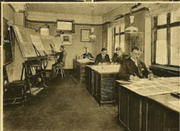
Teilansicht der technischen Büros
